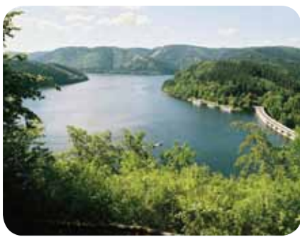
Blick auf die Stauwehr
