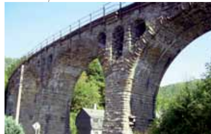
Überspannung des Tales durch Viadukt
